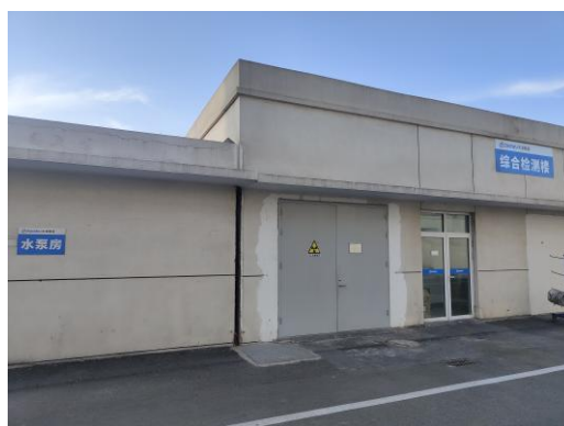
综合检测楼、南侧水泵房
