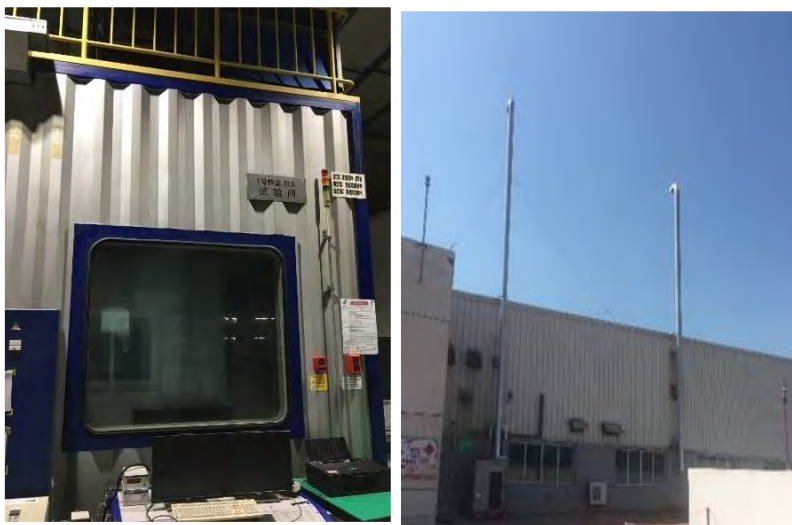
图2.4-14 密闭试验间及试验废气排气筒
