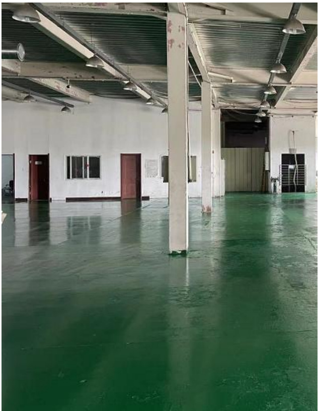
图2-5 本项目搬迁后租赁厂房现状图
