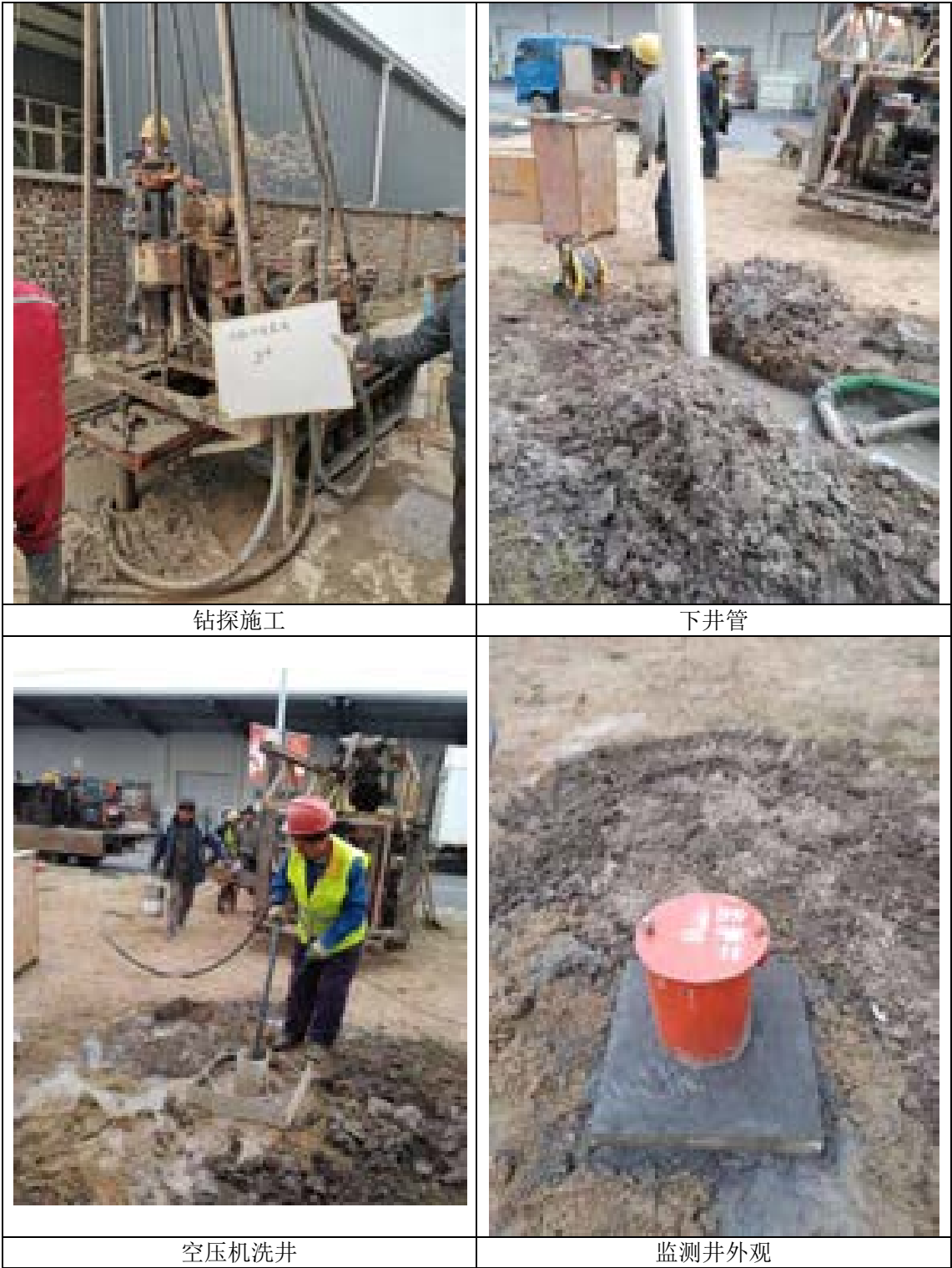
照片 3.1-1 水文地质钻探施工照片
