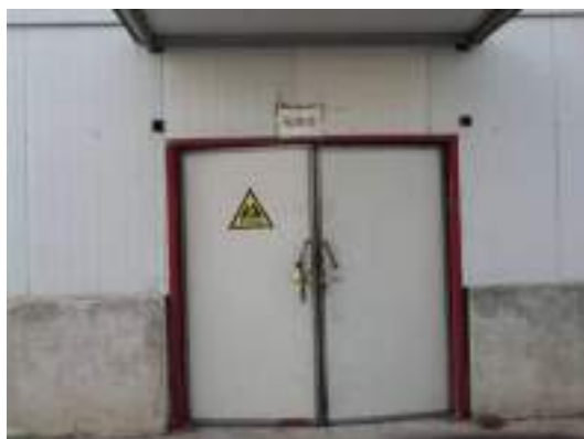
危险废物暂存间（外）
