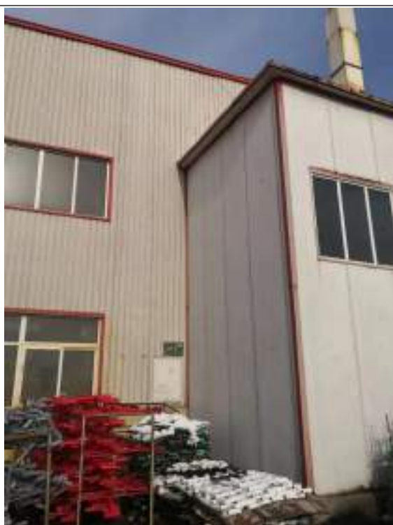
磷化排放口（P2）及标识牌
