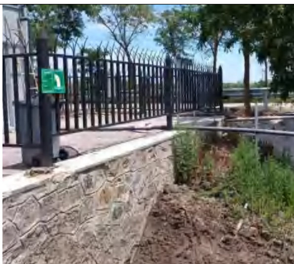
图 14 500t/d 污水排口
