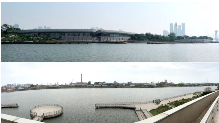
图 4-2 河滨公园码头点位现状照片
