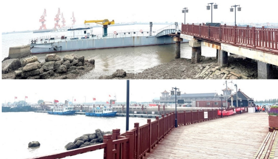
图 4-35 中心渔港码头点位现状照片
