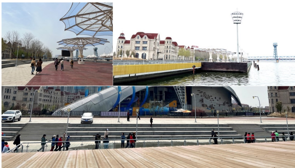
图 4-12 天津极地海洋世界码头点位现状照片
