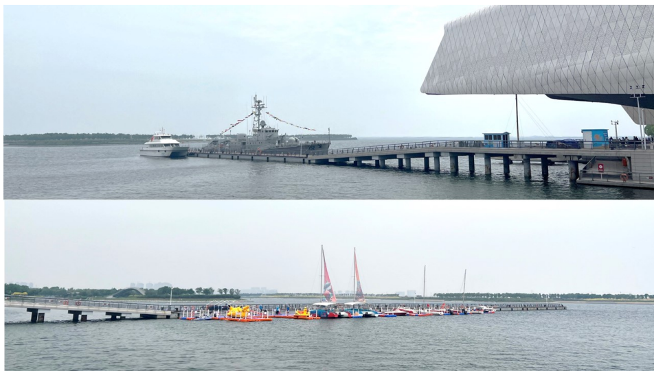
图 4-30 国家海洋博物馆码头点位现状照片
