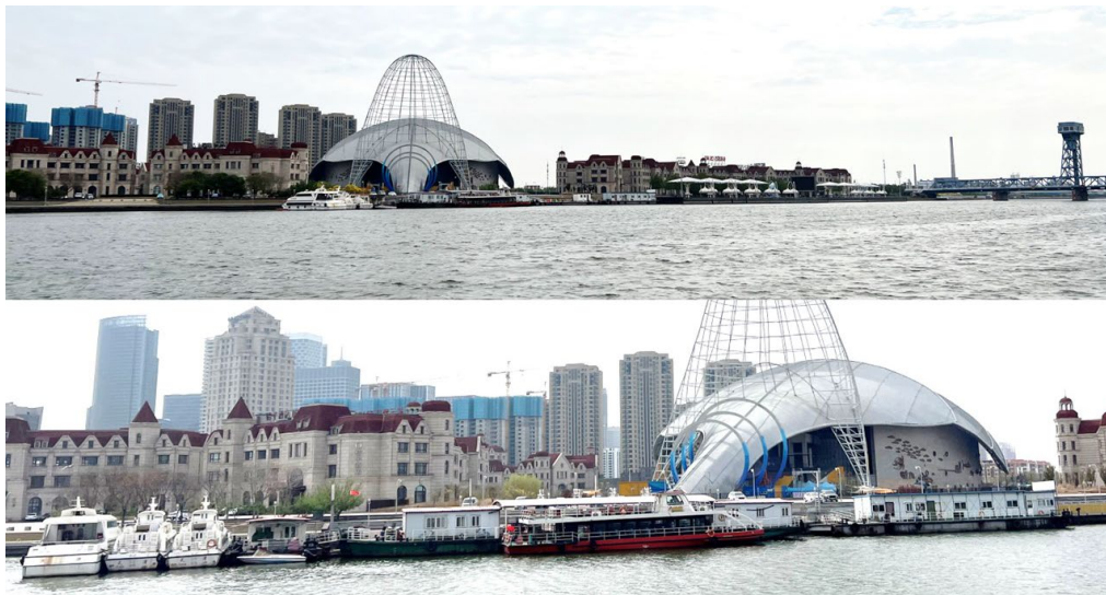
图 4-11 天津极地海洋世界码头点位现状照片
