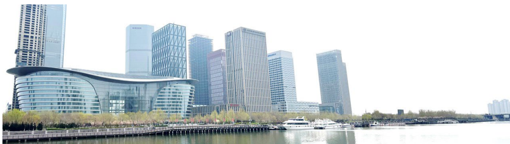
图 4-20 会展中心广场码头点位现状照片
