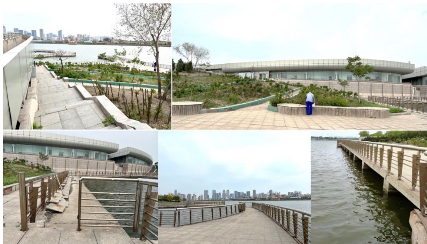
图 4-3 河滨公园码头点位现状照片
