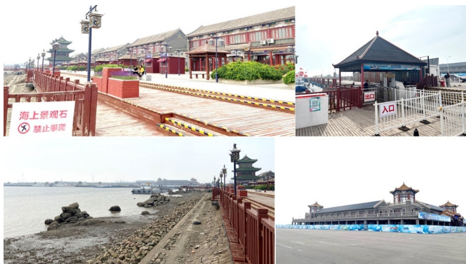
图 4-36 中心渔港码头点位现状照片
