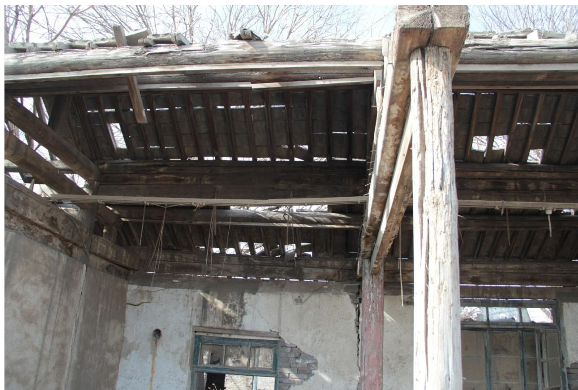
西配殿现状照片（2015 年自摄）
