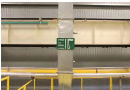
照片 12-10 燃烧废气排放口 (FQ-KG357)
