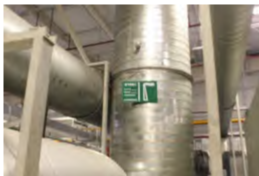
照片 12-12 补温炉、喷漆室废气 (FQ-KG359)
