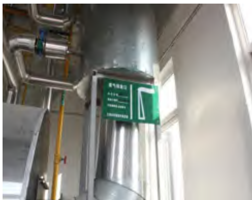
照片 12-9 燃烧废气排放口 (FQ-KG356)
