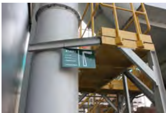
照片 12-8 抛丸废气排放口 (FQ-KG355)
