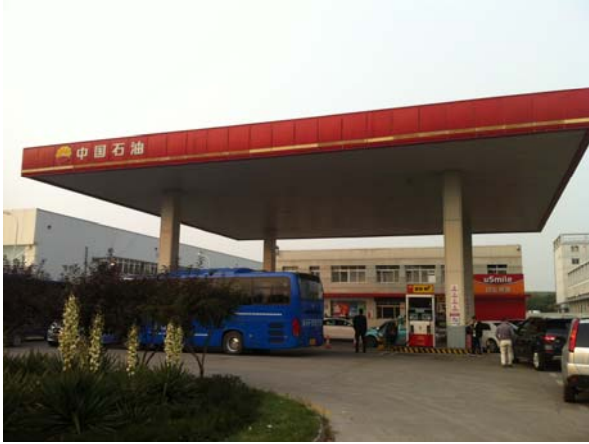
现状加油站运行情况（站区全貌）
