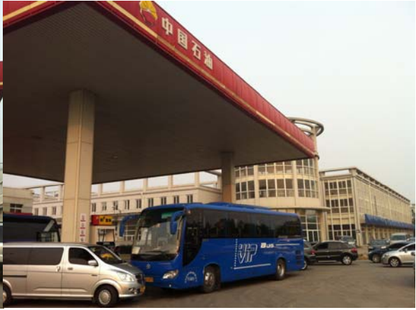
项目加油罩棚区
